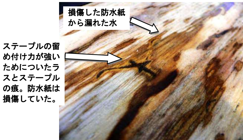
写真-3 ラスの留め付け力が強すぎてアスファルトフェルトを損傷して漏水
