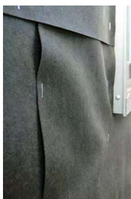
写真-4 雨により波打った防水紙
